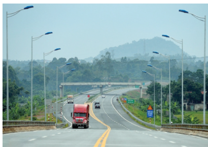
Dự án cao tốc Hà Nội - Lào Cai Ha Noi - Lao Cai Highway
