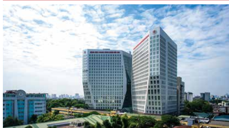
DỰ ÁN BỆNH VIỆN 108
