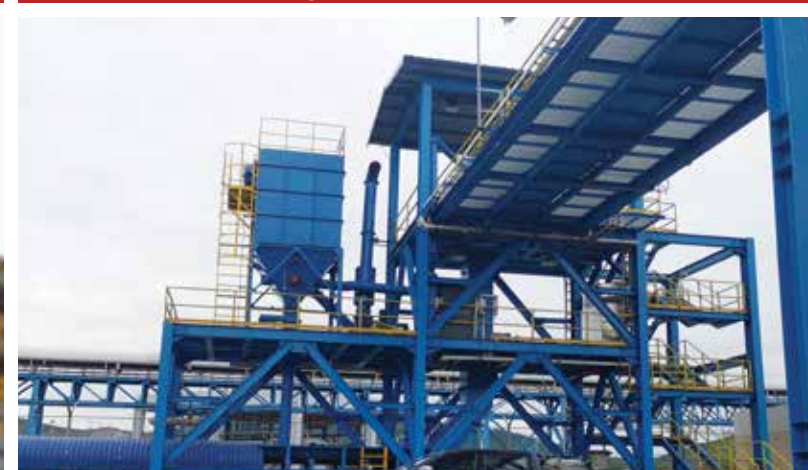
DỰ ÁN NHÀ MÁY NHIỆT ĐIỆN
